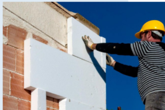
Operai al lavoro per installare un cappotto termico
